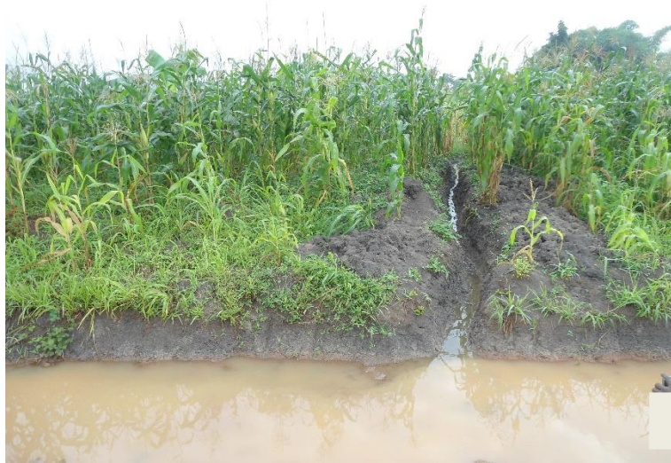
Photo 2 : Système d'évacuation d'eau à Issaba Prise de vue : Seydou, juillet 2015
