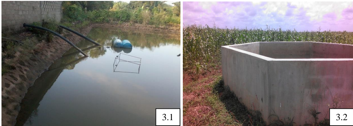
Planche 3 : Bassin stockage d'eau de CRAPP à Pobè centre (3.1) et Bassin stockage d'eau à Kpoulou (3.2)
