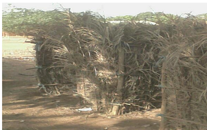
Photo 1: Latrine construite en matériaux précaires à l'EPP Illarè B
