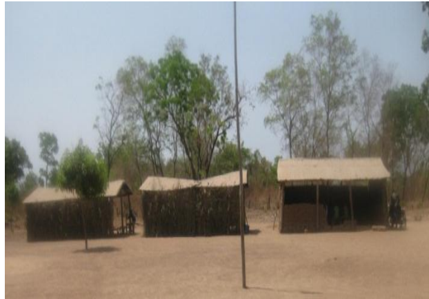
:Photo 3: Modules de classes construits en matériaux précaire à l'EPP-les pionniers
