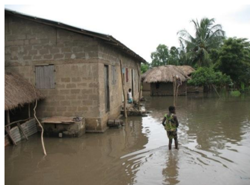
Photo 17 : Maison inondée à Atchannou
