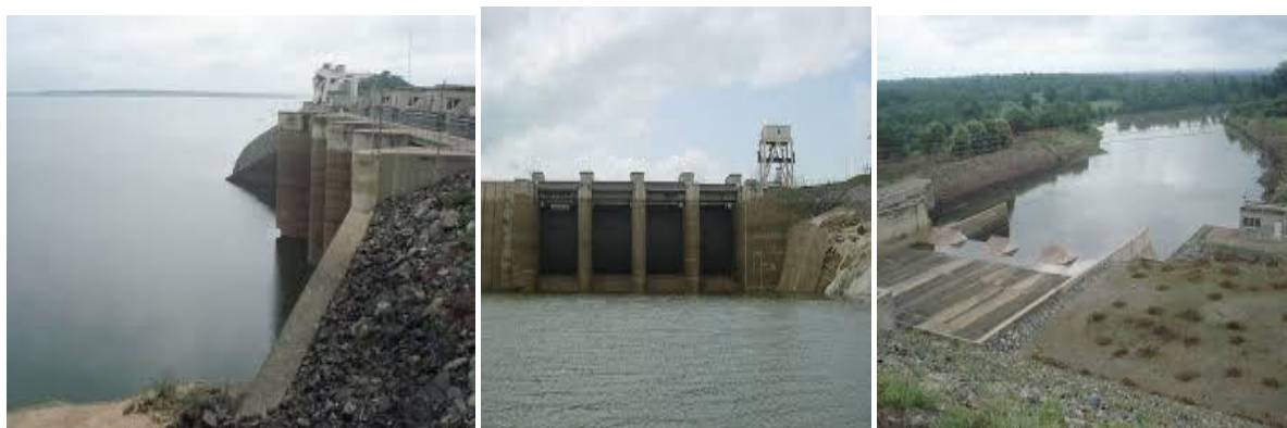
Photo 7 : Amont barrage de Nangbéto
