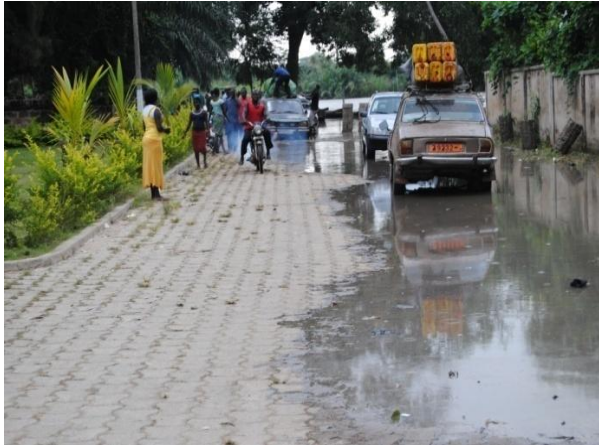
Photo 10 : Route inondée à Athiémé centre
