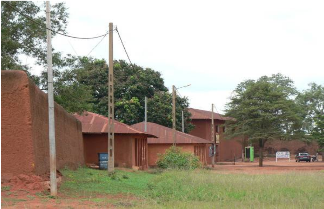
Photo 3 : Poteaux électriques et système de télécommunication devant le SPRA
