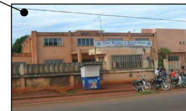
Caisse nationale de sécurité sociale, construite sur Agbodo
