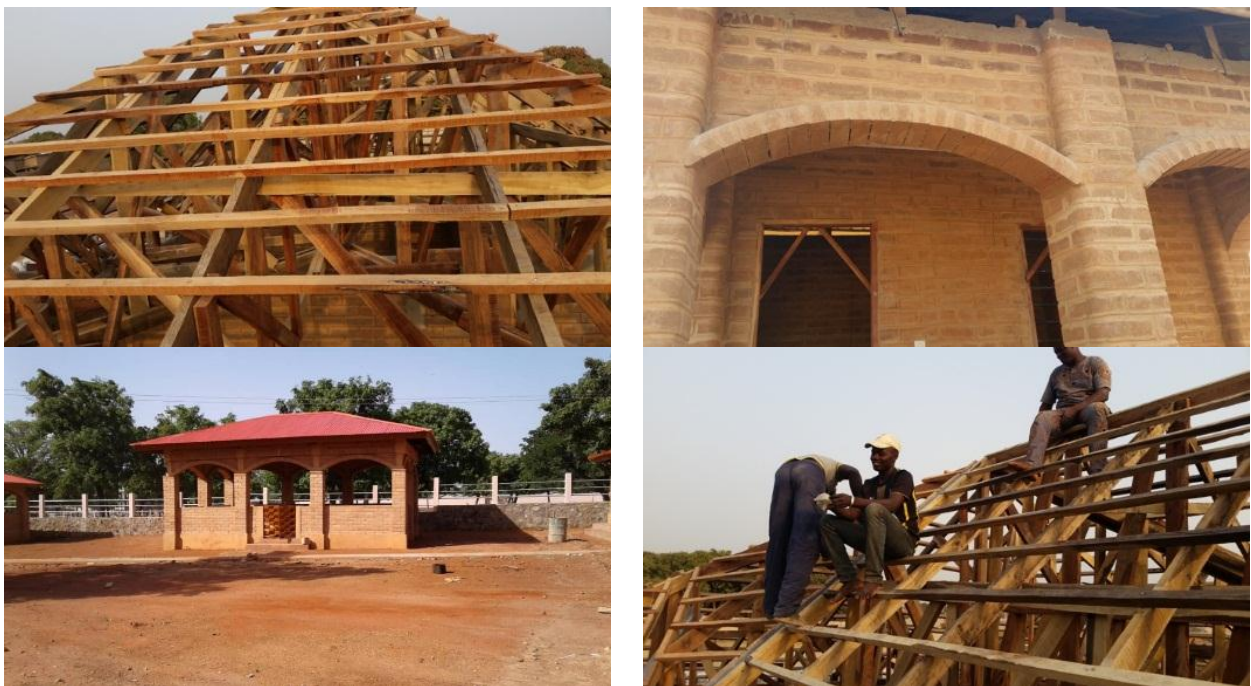
Planche 2 : Construction du marché à bétail à Kalalé
