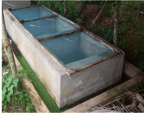
Figure 3.4 : Bassin de production entouré d'une rigole
