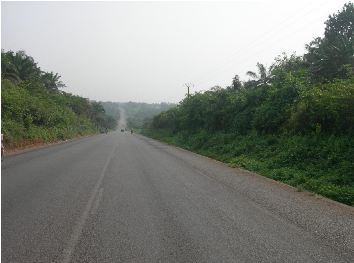
Photo n°2 : Route Idiroko (Nigeria )-Porto-Novo (Bénin) reconstruite en 2002-2003 (TAHO S.A. le 26 février 2014).
