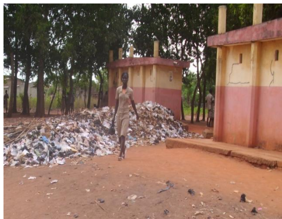
Photo 21 : Latrines se trouvant avec des tas d'ordures
