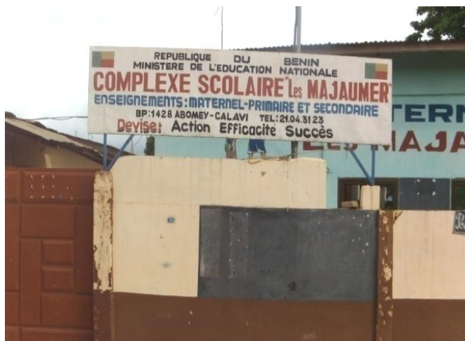
Photo 5 : Entrée du complexe scolaire "Les Majaumer".
