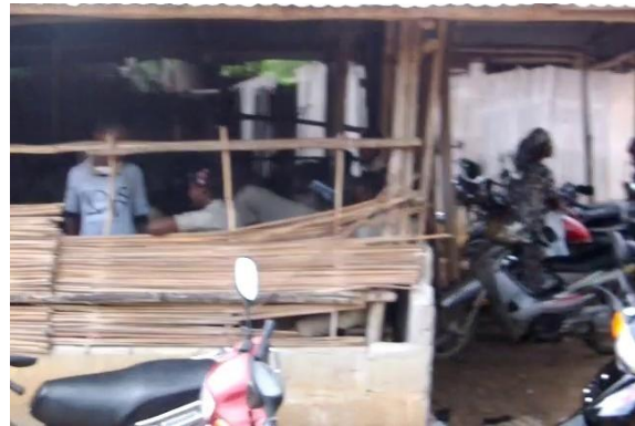
Photo 14 : Salle de classe servant de parking motos
