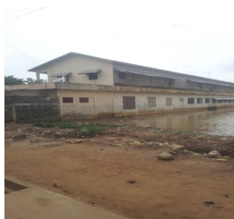
Photo 25 : Evacuation de l'eau par canalisation
