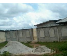
Photo n°12 : Des fils barbelés garnissant la clôture pour renforcer la sécurité d'un ménage enquêté /Source : Données de terrain, octobre 2014
