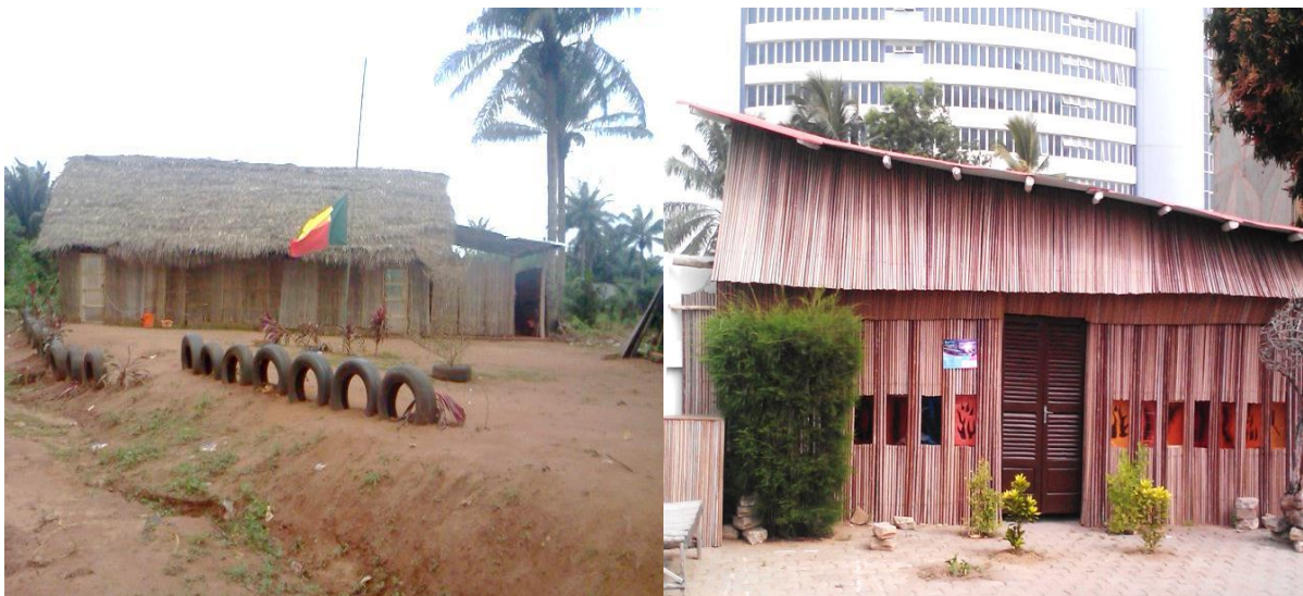
Planche 3 : Bâtiments érigés avec des matériaux issus du raphia Source : Données de terrain, 2015.
