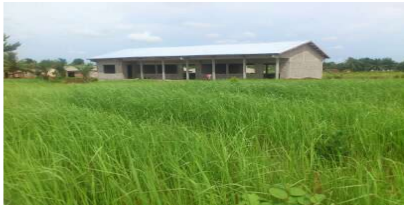
Photo n°4 : Module de classe construite par l'Arrondissement d'Akassato
