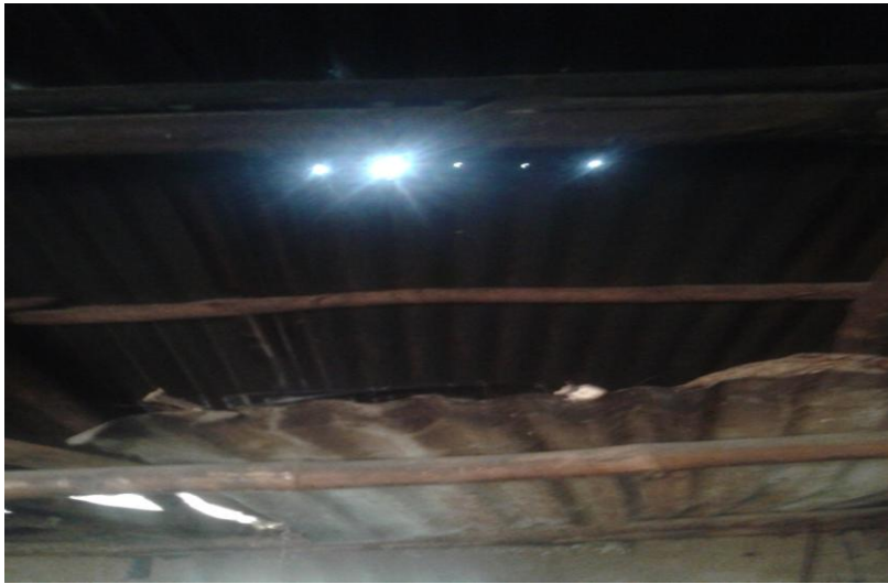
Photo 2 : Toiture d'un ménage bénéficiaire du PFO à Tré
