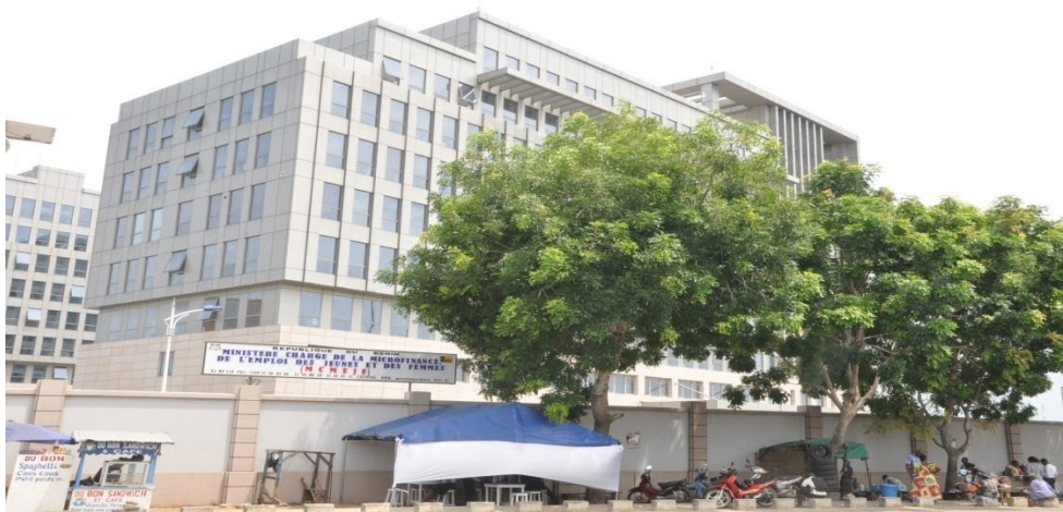
Photo 1 : Vue de profil du bâtiment abritant le MCMEEJF
