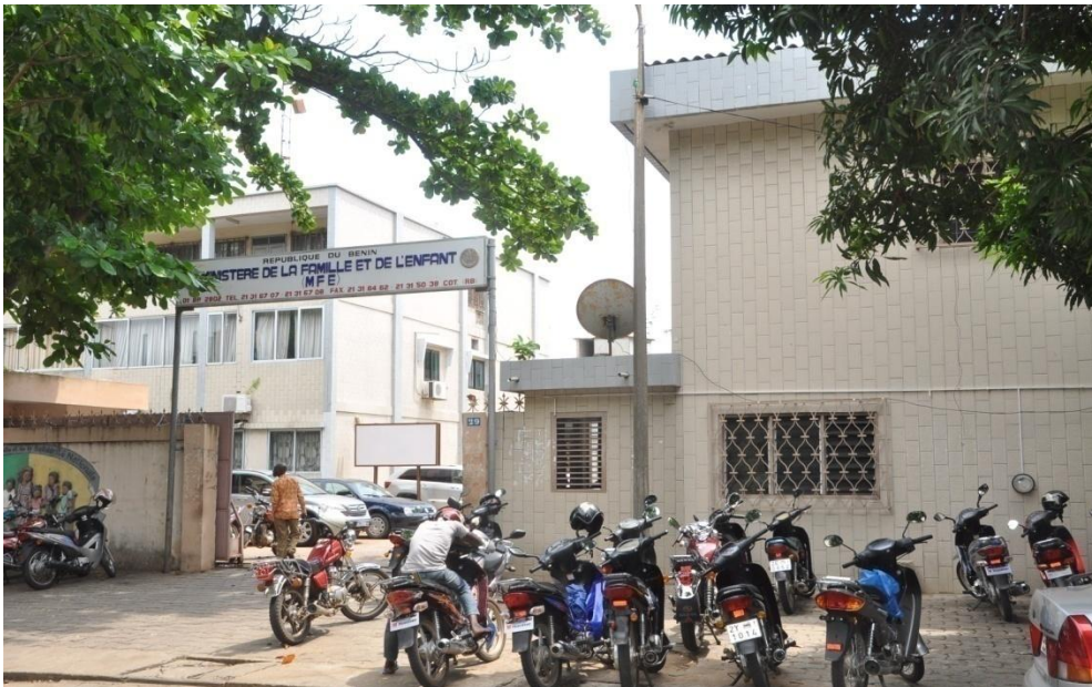
Photo 2 : Vue de face du bâtiment abritant le MFASSNHPTA
