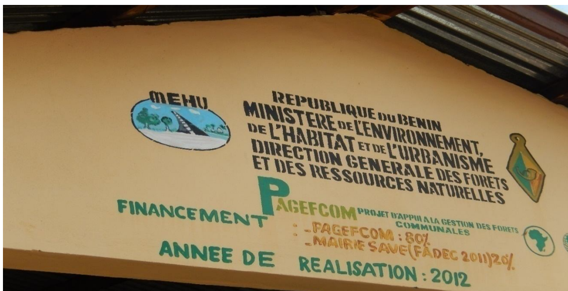
Photo 6 : hangar construit par PAGEFCOM au marché central de la ville de Savè
