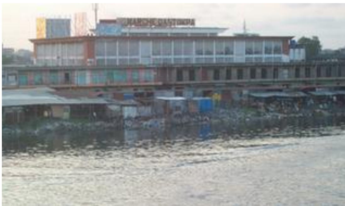
Photo 1: Vue latérale du marché Dantokpa Source : Cliché Dégboé Rolande, octobre 2015.
