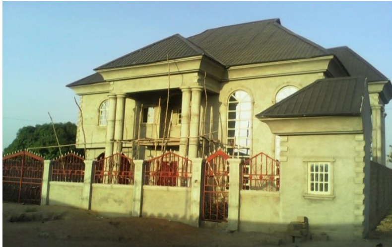
Photo 10 : Immeuble en construction au quartier Nima
