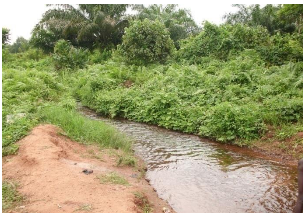
Photo 15 : Comblement de la rivière Aguidi à Fouditi dans l'arrondissement d'Ikpinlè
