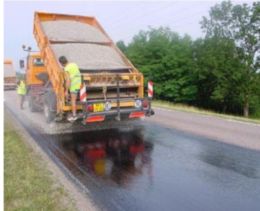
Photo 8 : Répandage gravillon faisant suite à un répandage de liant [12]
