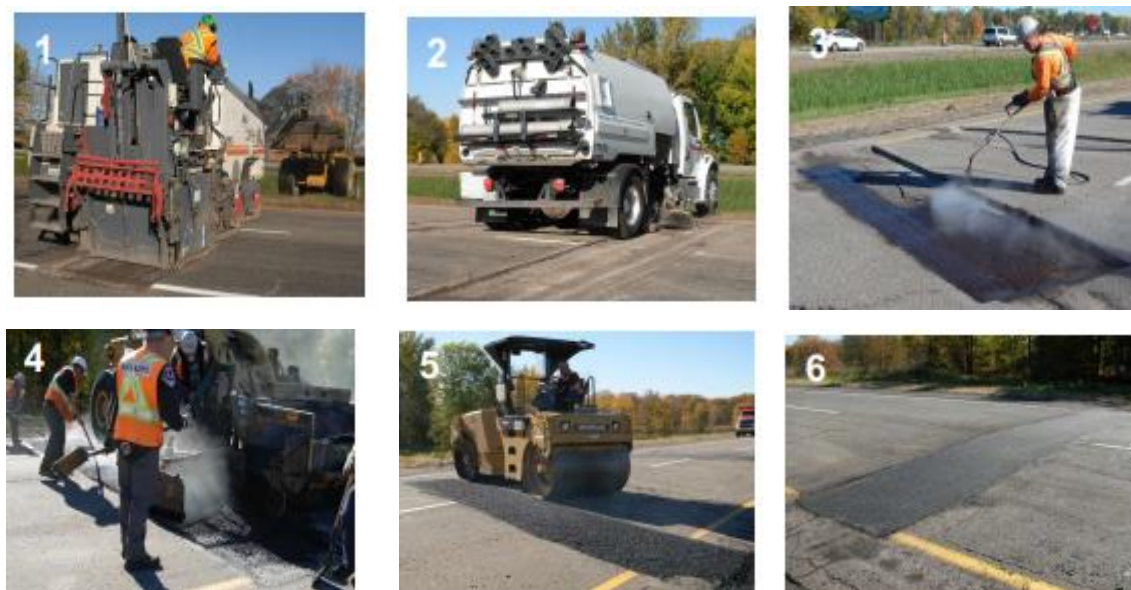
Photo 12 : Les étapes de réparation permanente
