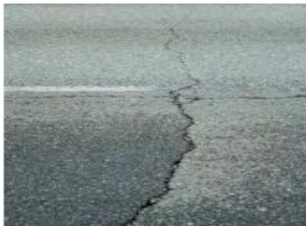
Photo 4 : Fissures thermiques [11]
