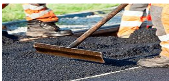
c) Enrobé de bitume polymère
