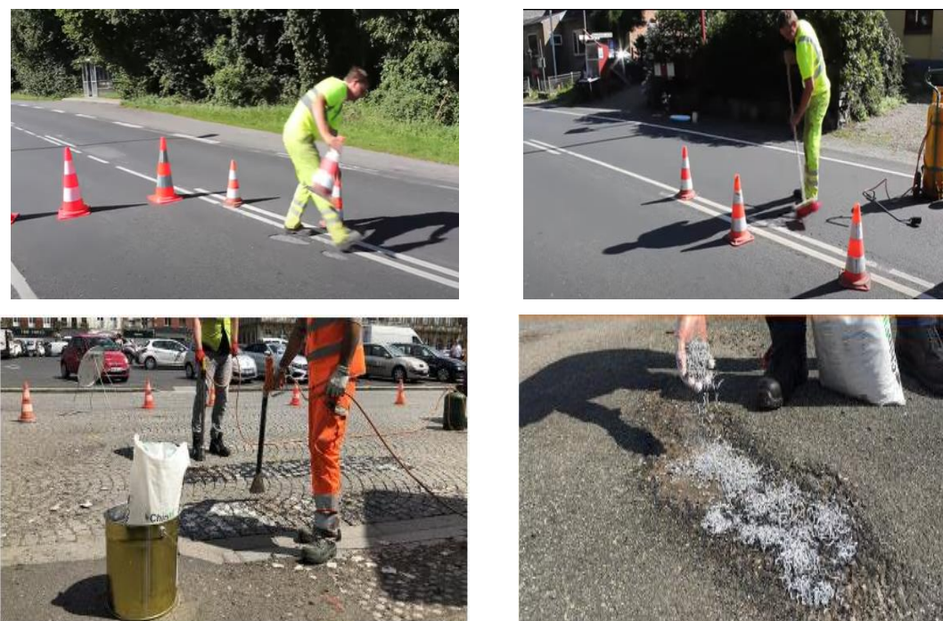
Photo 15 : Réparation des nids-de-poule avec ChipFill [29]
