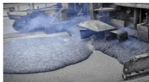
b) Enrobé d'asphalte coulé
