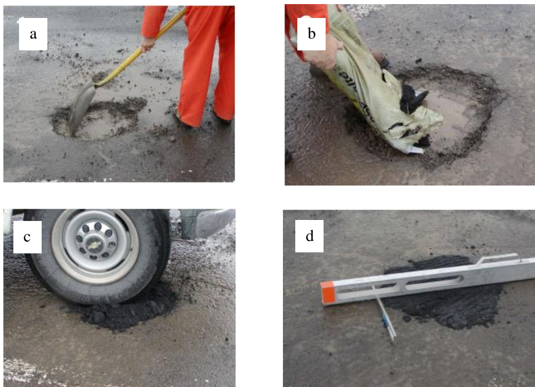
Photo 11 : Réparation urgente des nids-de-poule [28]
