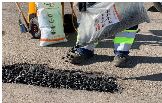
Photo 14 : Mise en œuvre d'AggreFill [29]
