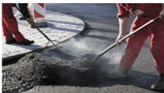
a) Asphalte mélangé à chaud.
