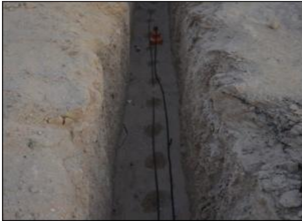
Figure 13 : Installation et test du réseau hydratant [9]
