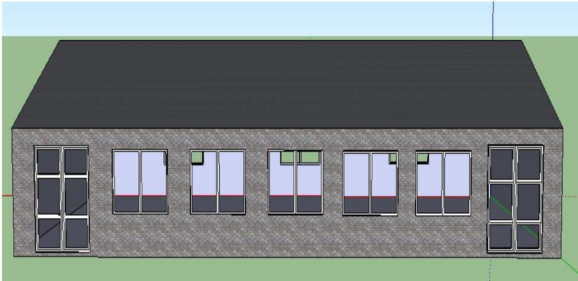
Figure 2. 2 : Façade principale du bâtiment orienté Sud-Nord
