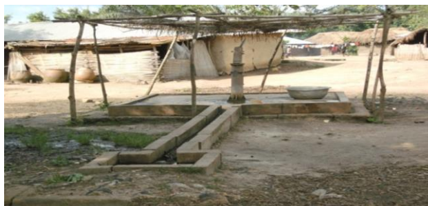
Photo 7 : Un Forage équipé de Pompe à Motricité humaine à Tohonou Prise de vue : KPEHOUNOU , Septembre 2014
