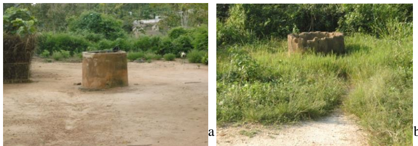
Planche 5 : Puits publics sans margelle ni couverture à Gonfiocomè (a) et Zounmè (b) Prise de vue : KPEHOUNOU, Septembre 2014
