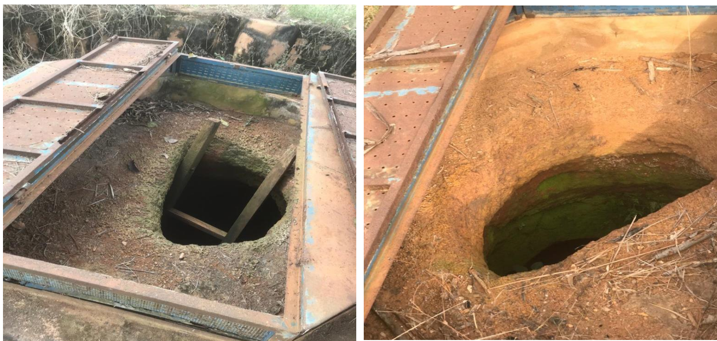
Image n°2 : Entrées souterraines avec couvertures métalliques
