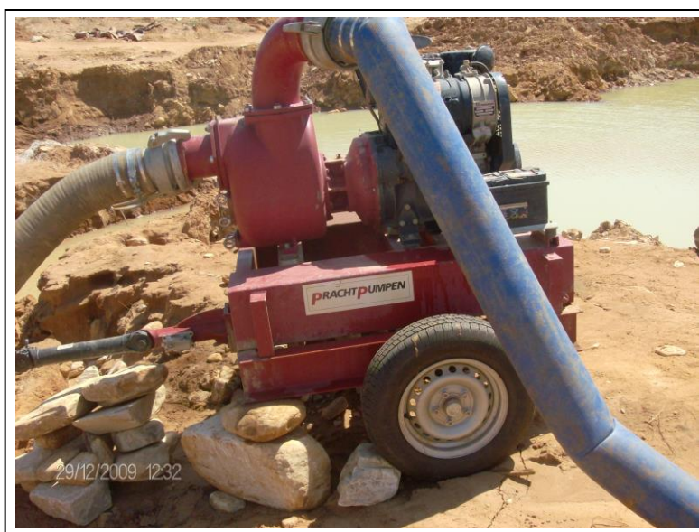
Photo 7 : Une motopompe aspirant l'eau pour le lavage de l'or
