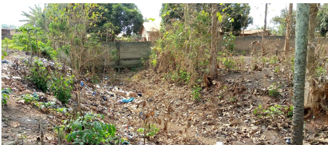
Photo 7 : Fossé comblé par des ordures ménagères à Adandokpodji, 07°11'16.6'' N et 001°58'54.1''E, cliché de KOUDAKPO I. A., février 2021
