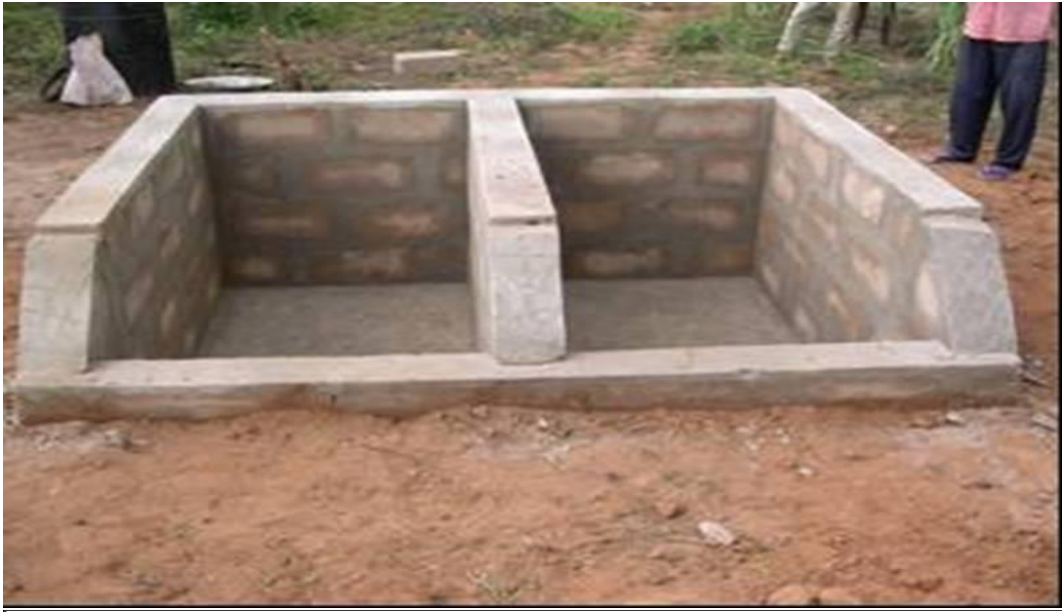
Photo 5 : Finition de la fosse
