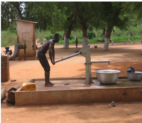
Photo 5 : Forage équipé de pompe manuelle à Sègbohòuè II Prise de vue : Ahodjidé, avril 2013
