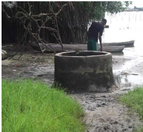
Photo 3 : Puits traditionnels sans margelle à Agbanto I Prise de vue : Ahodjidé, avril 2013
