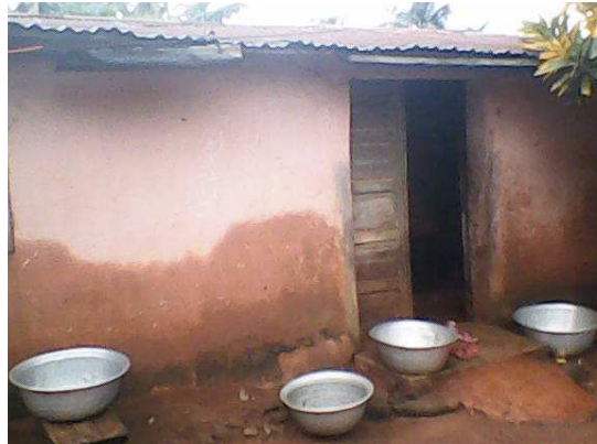
Photo 2 : Mode de récupération des eaux de pluie à Sègbohoulè I Prise de vue : Ahodjidé, avril 2013
