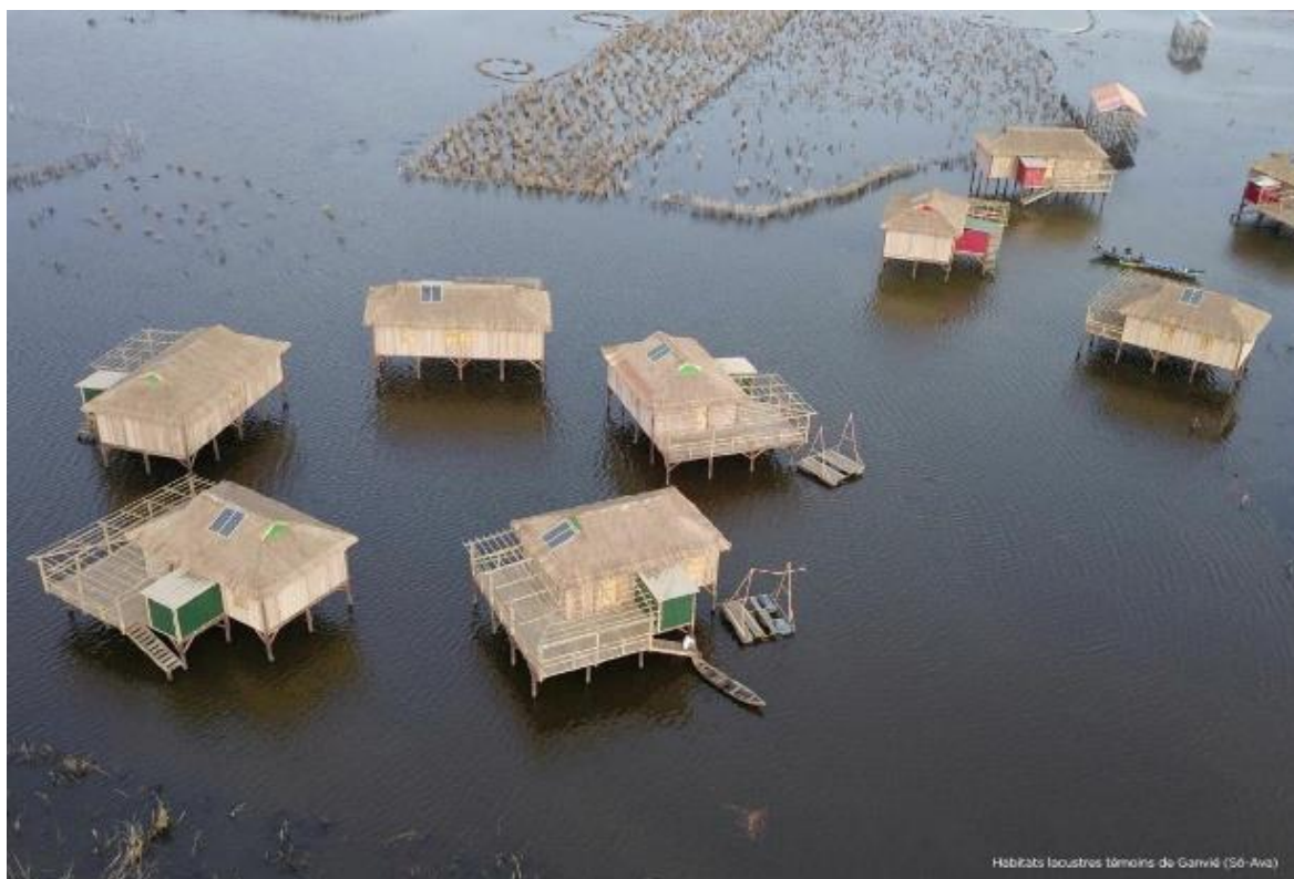
Image N° 5 : Maison sur pilotis de la Cité lacustre de Ganvié
