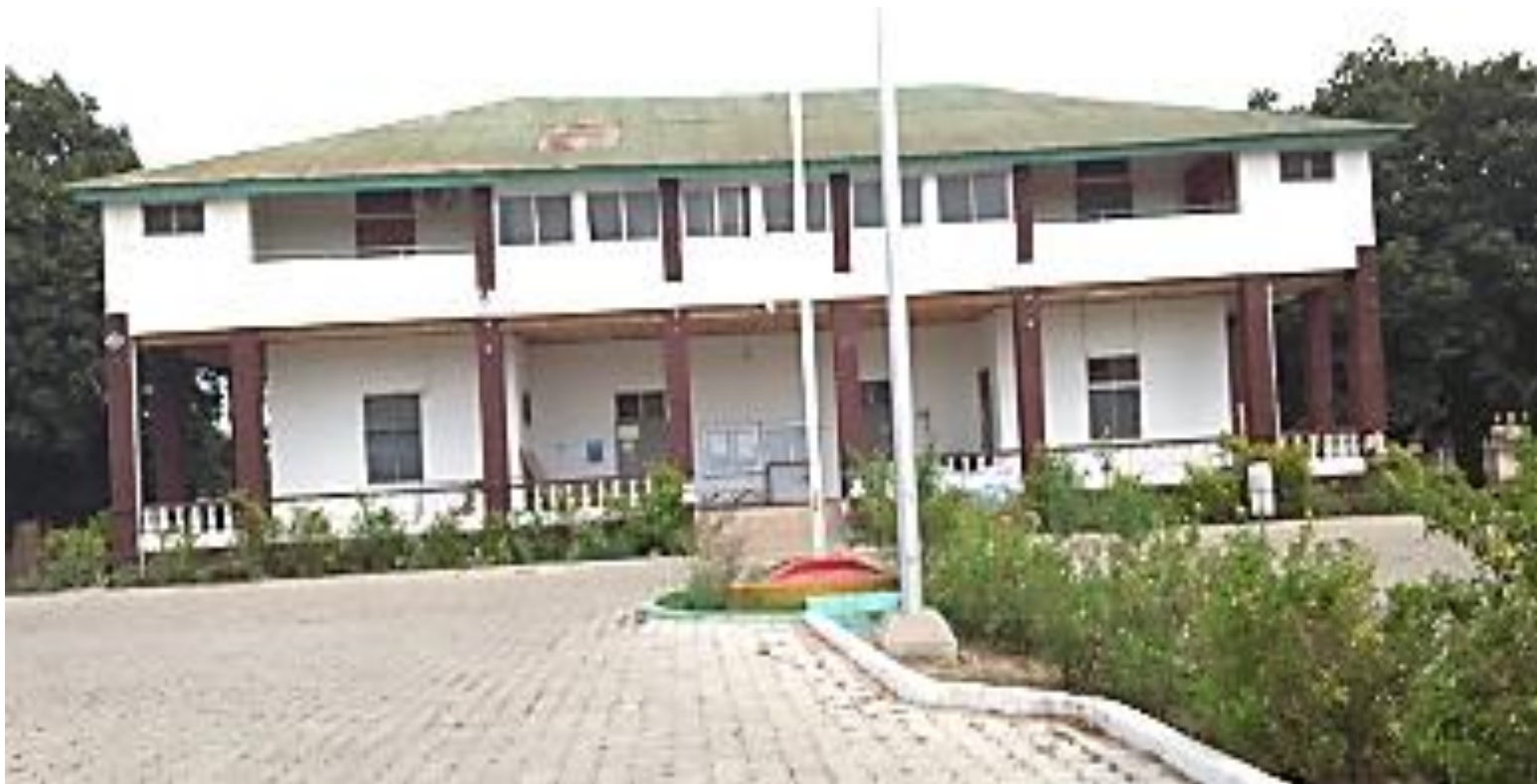
Photo 1 : Une vue de la façade de la Résidence du Commandant de Cercle,
