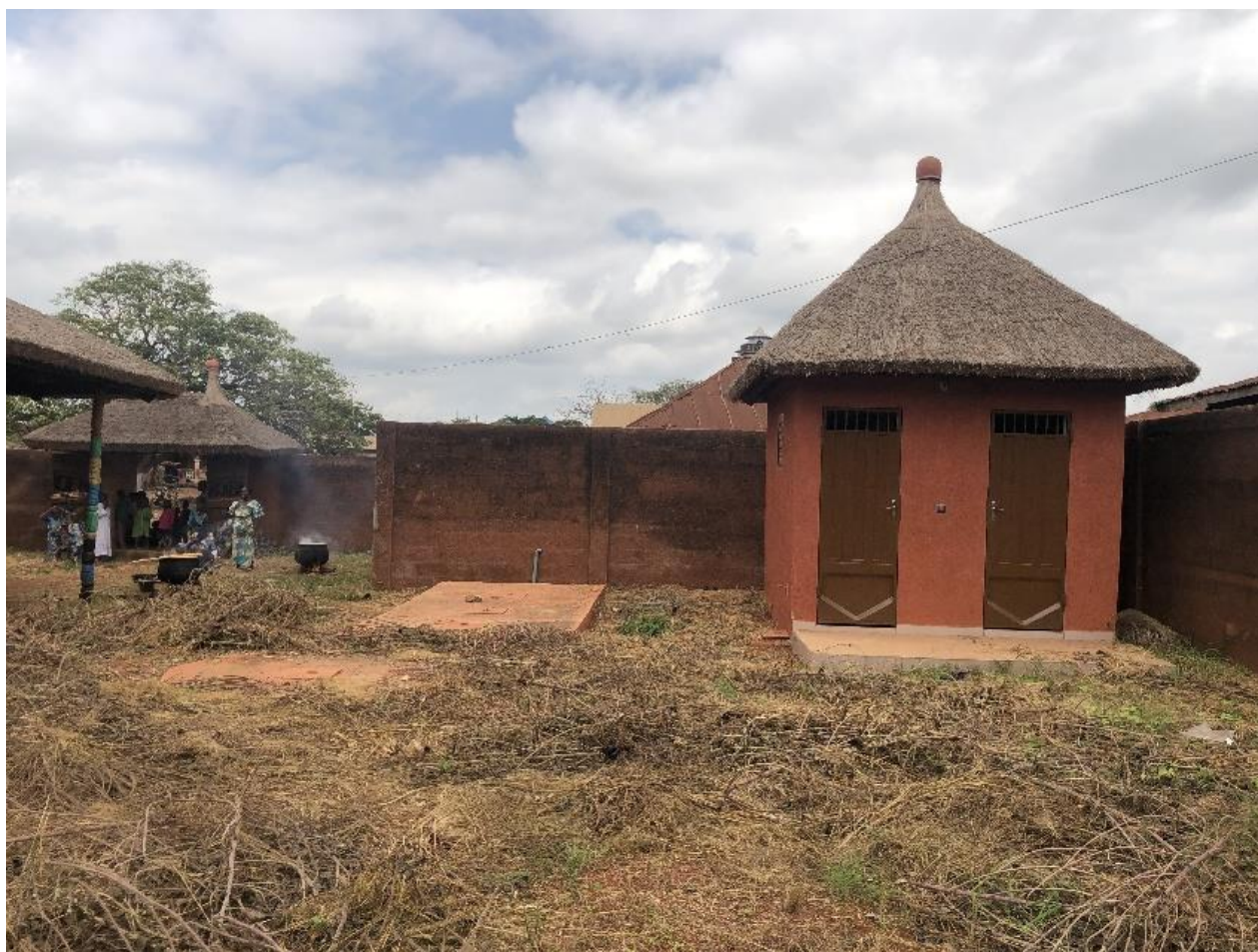
Photo n°7 : Toilettes modernes nouvellement construites dans le musée
