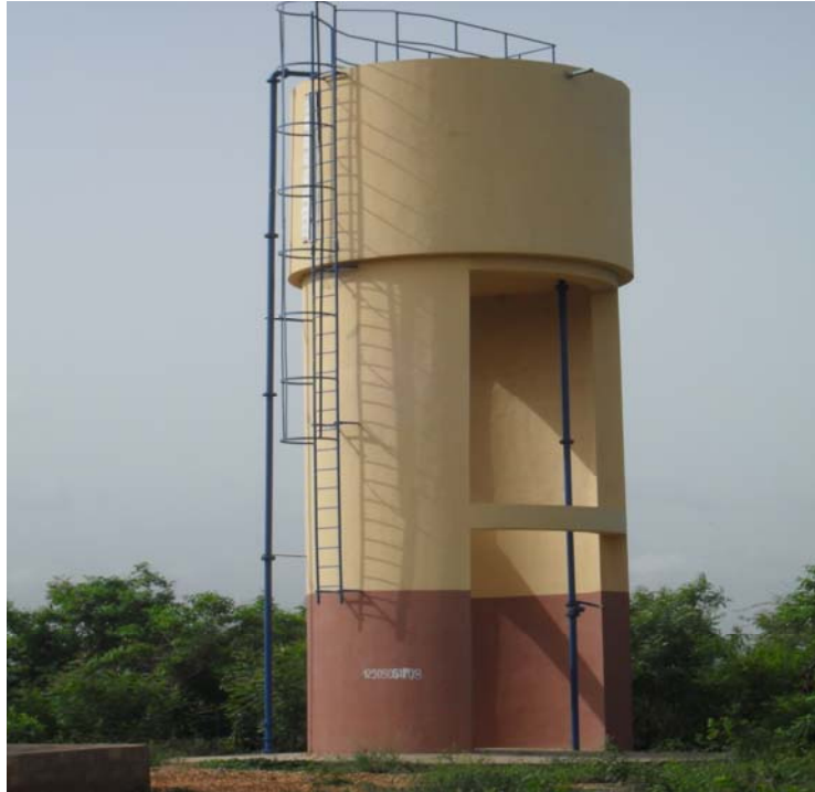
Photo N°4 : Un mini PEA (Point d'eau Autonome) réalisé en 2009 dans l'arrondissement de TANWE-HESSOU/ZOGBODOMEY desservant la population en eau potable (Fonctionnel).
