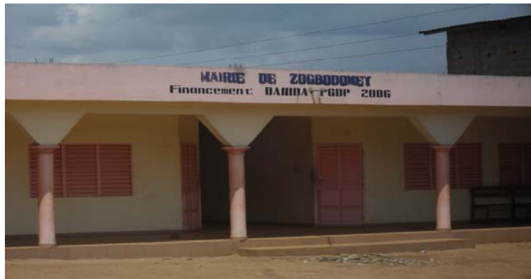
Photo N°16 : Une vue partielle du bloc administratif de la commune de ZOGBODOMEY réalisée en 2006 grâce au partenaire DANIDA /PGDP.
