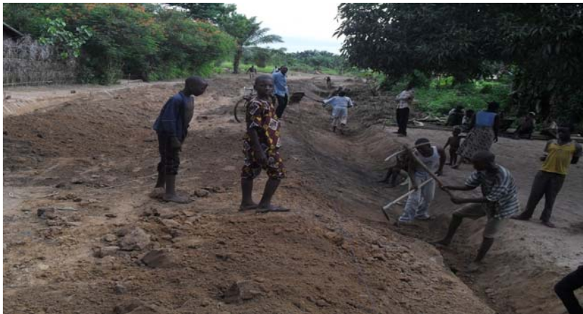
Photo N°5 : Un chantier de réalisation de piste rurale dans ZOUKOU/ ZOGBODOMEY en 2011 exploitant la main d'œuvre locale avec la Méthode HIMO (Haute Intensité de Main d'Œuvre).
