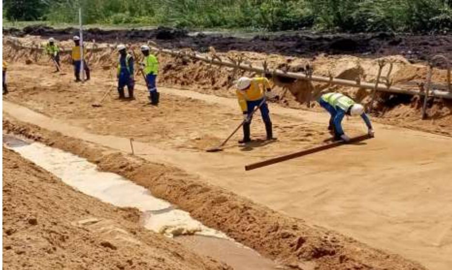
Photo 6: L'implantation des pickets et nivellement de l'assise
