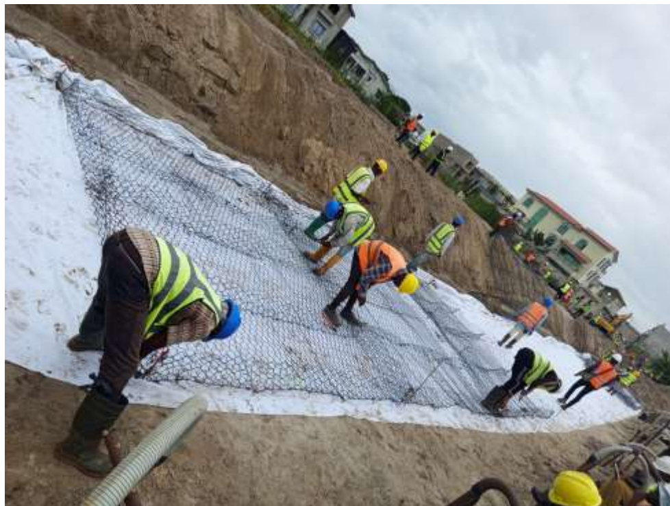
Photo 8: La pose des cages
