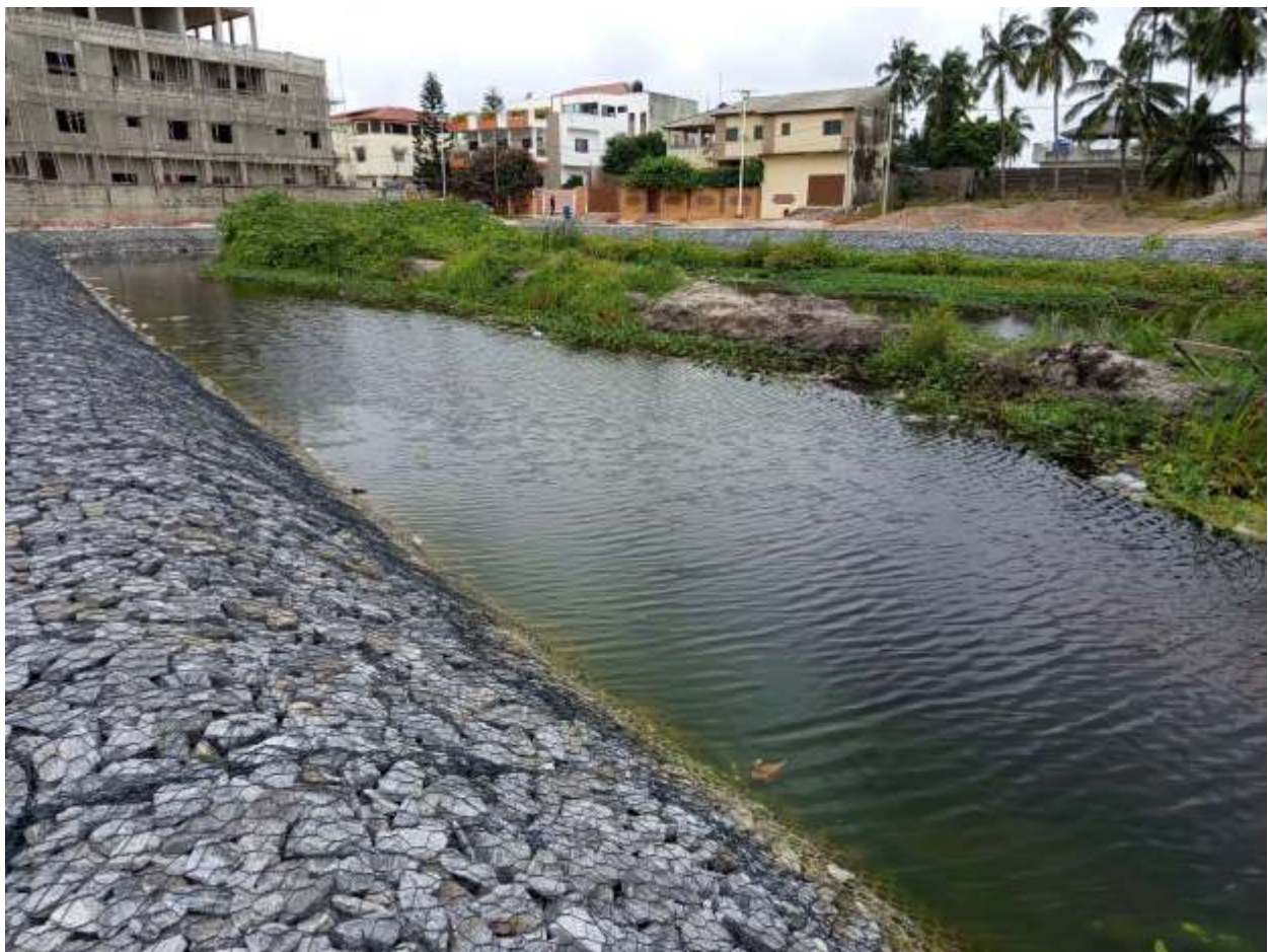
Photo 16: Matelas Reno mis en place
