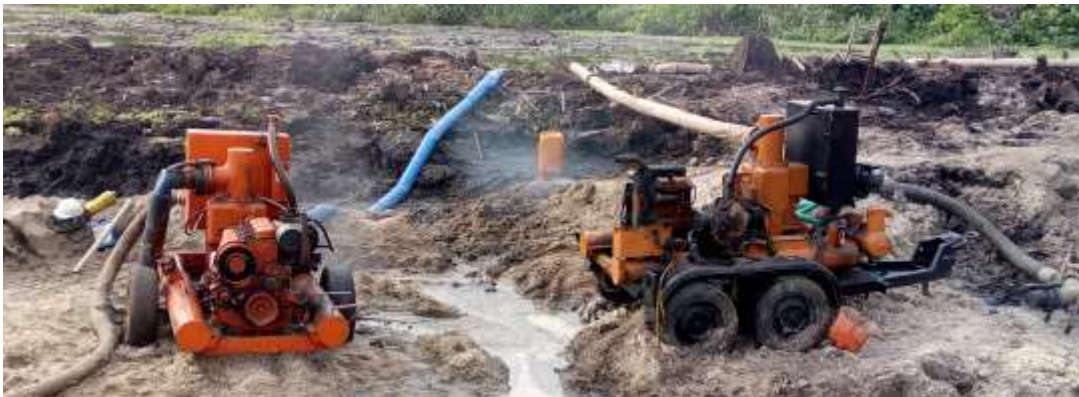
Photo 5: Mise en place du rabat nappe
