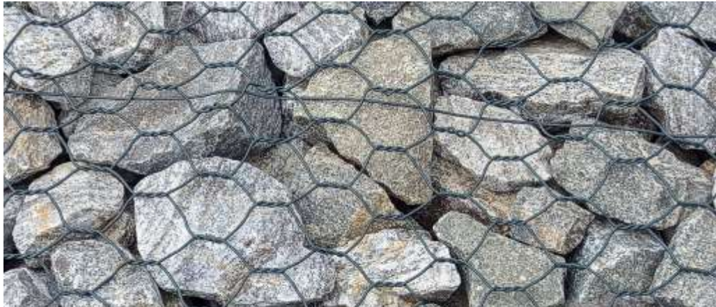
Photo 10: Remplissage et fermeture des cages
