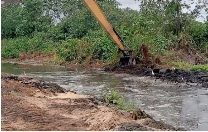
Photo 2 : Création du batardeau
