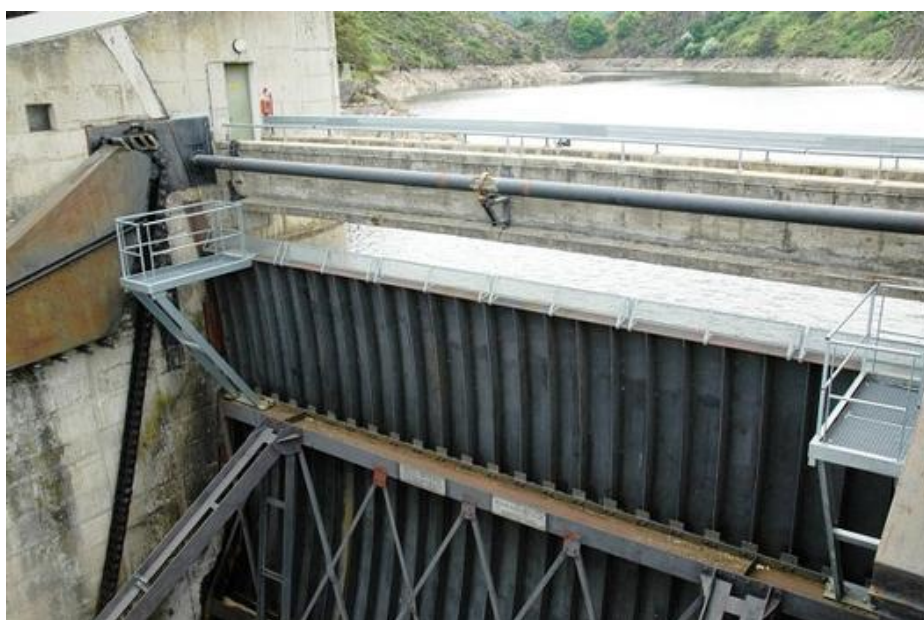
Photo 6: Barrage de grangent (Saint-Etienne/Chambles, 1957)
