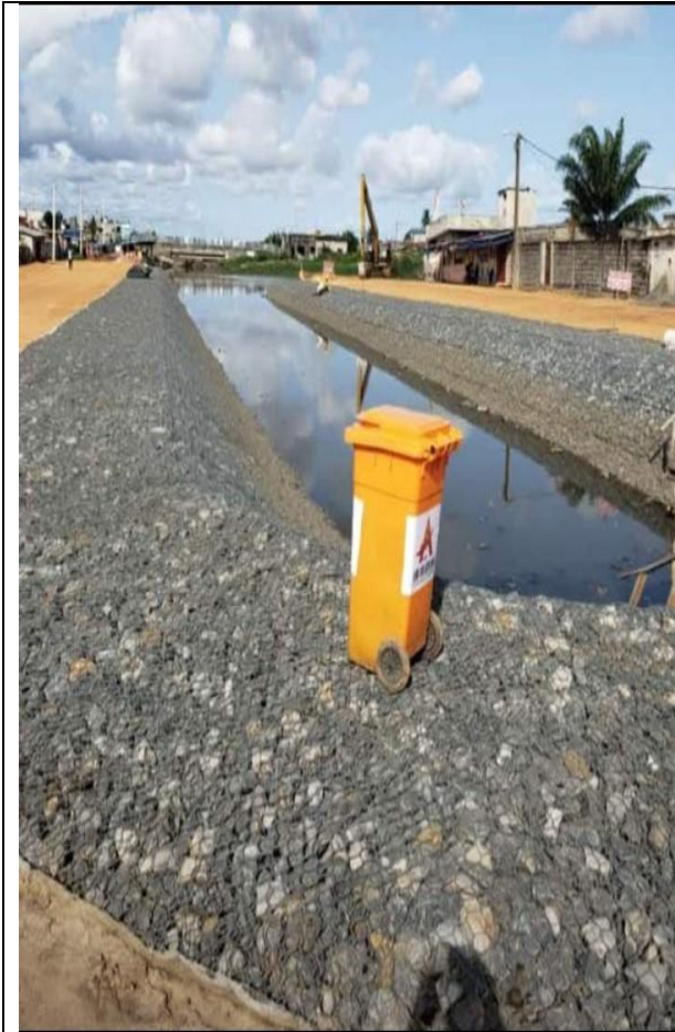
Photo 1 : Aménagement du bras du bassin de rétention Pa3
