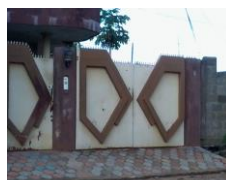
Photo n°13 Du fer pointu et un système de vidéo surveillance à l'entrée d'un ménage enquêté /Source : Données de terrain, octobre 2014
