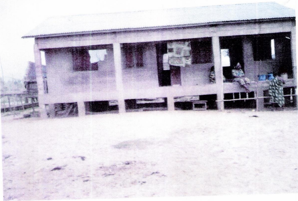
Photo I-a : Une construction moderne aux Aguégus Source : Cliché OWOLEGBON, janvier 2011
