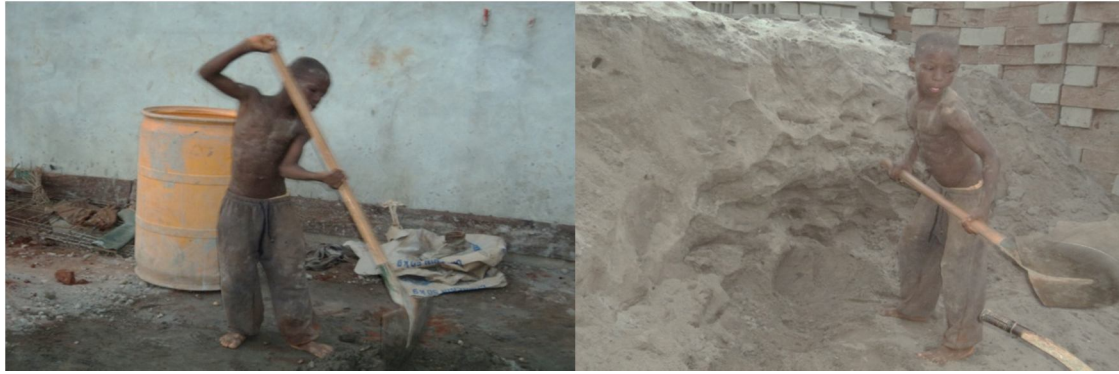
Photo 2et 3 : un apprenti maçon entrain de mélanger du sable au ciment.
