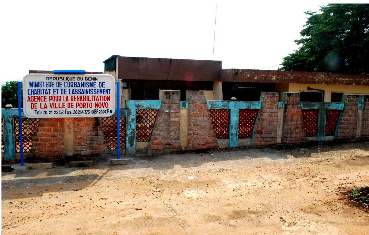
Photo 6 : Siège de l'Agence pour la Réhabilitation de la Ville de Porto-Novo Source : cliché DOSSOU, Février 2014
