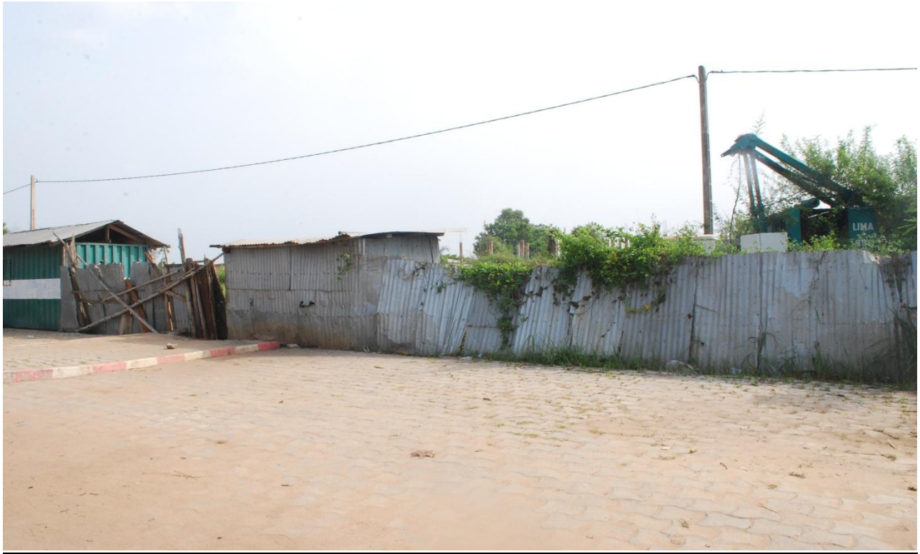
Photo 1: chantier de construction de la HAAC abandonné Source : cliché DOSSOU, Février 2014
