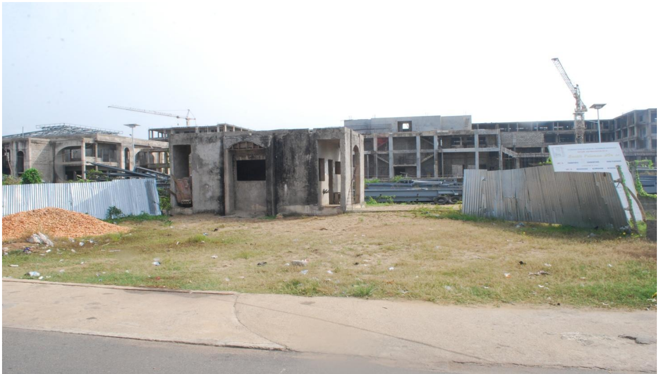
Photos 3 : Chantier de construction du siège de l'Assemblée Nationale (vue de profil) Source : cliché DOSSOU, Février 2014
