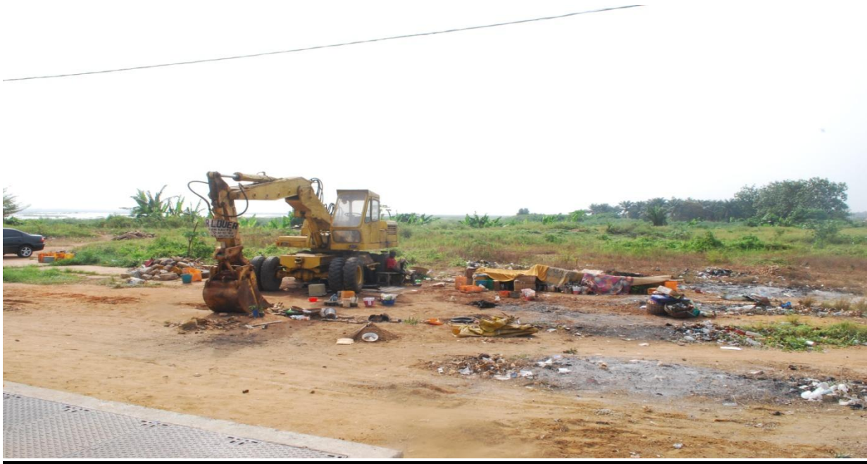
Photo 5 : berge lagunaire Côté-Ouest (vue de l'entrée du pont de Porto-Novo)
