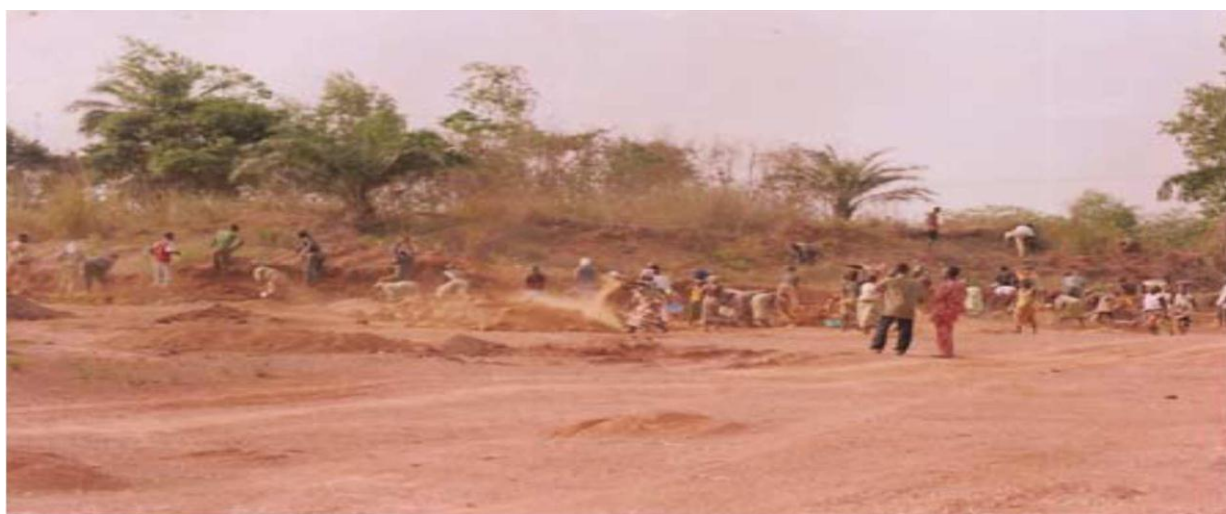
Photo n°2: Gerbage manuel de graveleux latéritique à Sakété (Plateau).
