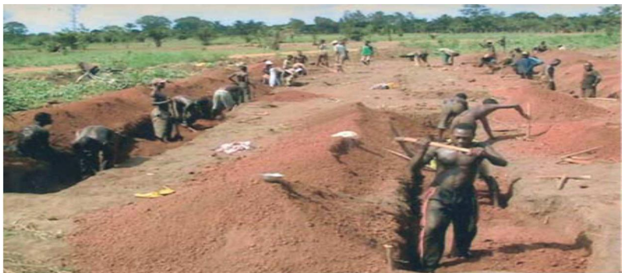
Photo n°1: Gerbage manuel de graveleux latéritique à Bohicon (Zou).
